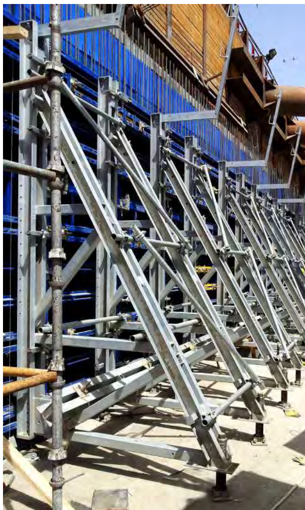
Bloc modular de sprijin, construit prin combinația cadrelor atașabile 1,50 m.
